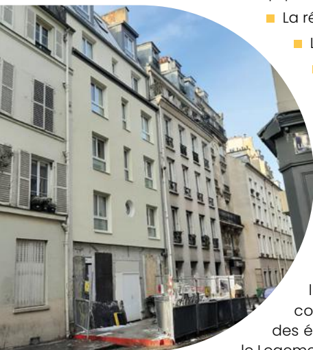
Exemple de chantier en cours
